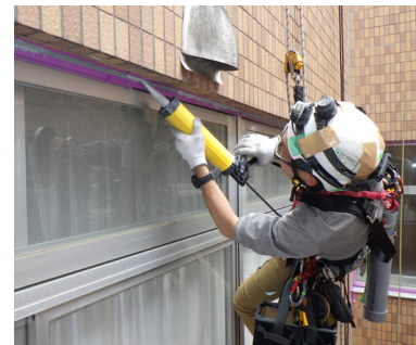
シーリング工事
