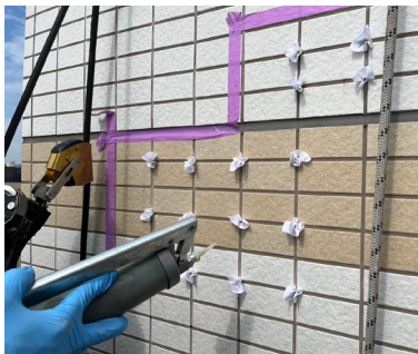
タイル補修工事
