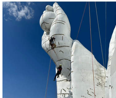
補修・塗装工事
